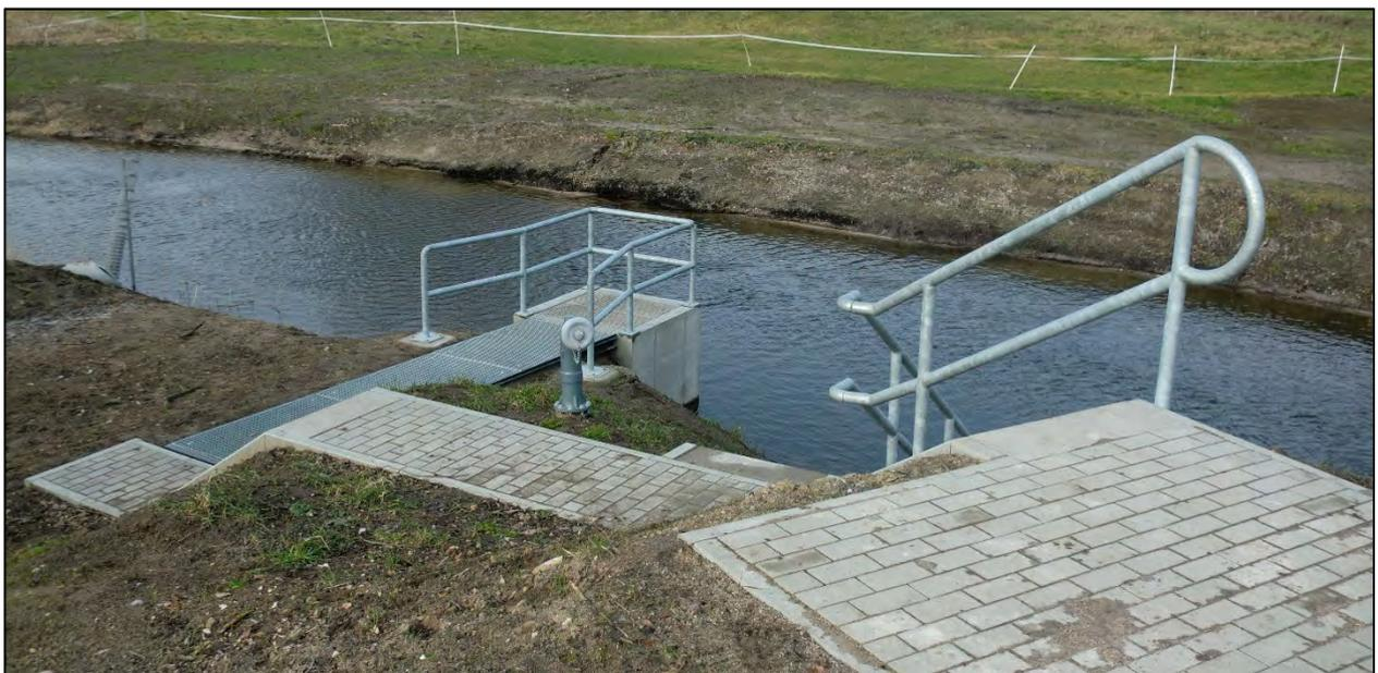
Abbildung 9-11: Beispiel einer gebauten Löschwasserentnahmestelle an der Warnow in Tempzin
