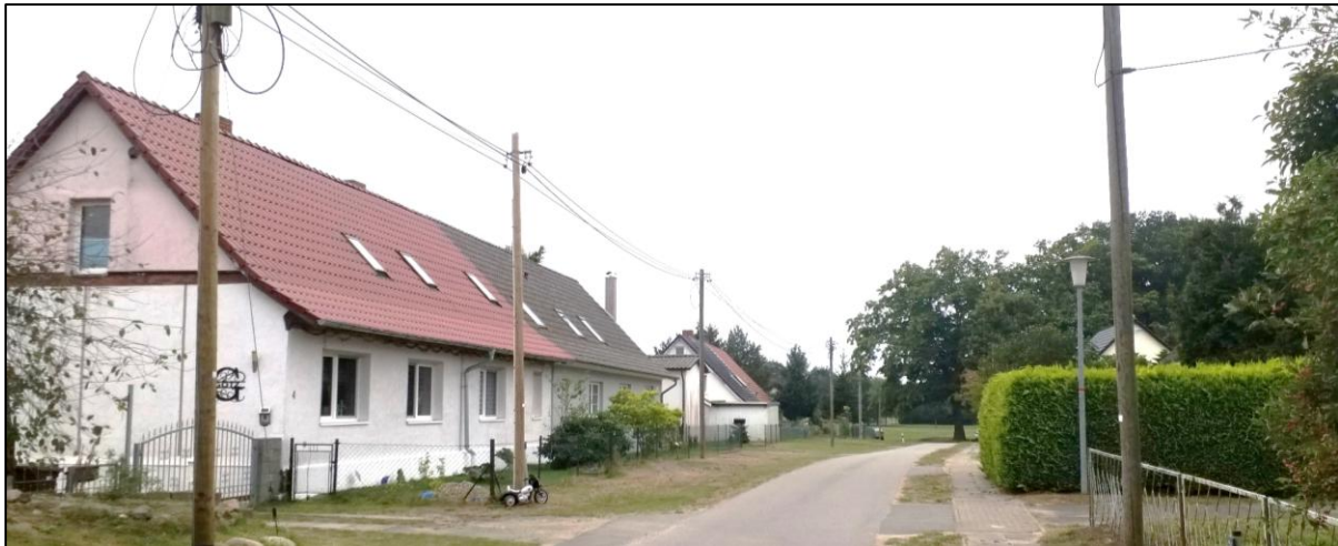
Abb. 5 Typische Wohnbebauung im Gemeindegebiet in Form von offener Bauweise, Ortsteil Oebelitz Quelle: IPO Unternehmensgruppe GmbH, eigene Aufnahme
